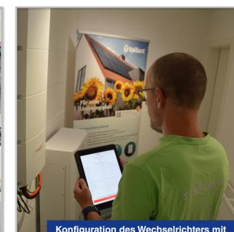
Konfiguration des Wechselrichters mit der Hersteller-App. Foto: D. Buchmann
